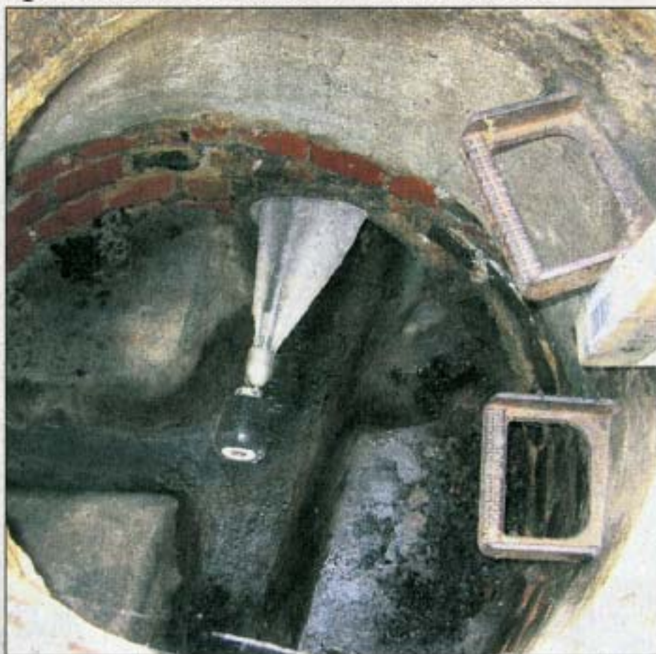
Wasser marsch: Von acht Düsen gesteuert startet der Spülkopf mit Kamera auf Inspektionstour durch Kanalsysteme. FOTOS: NH/BUSCH
